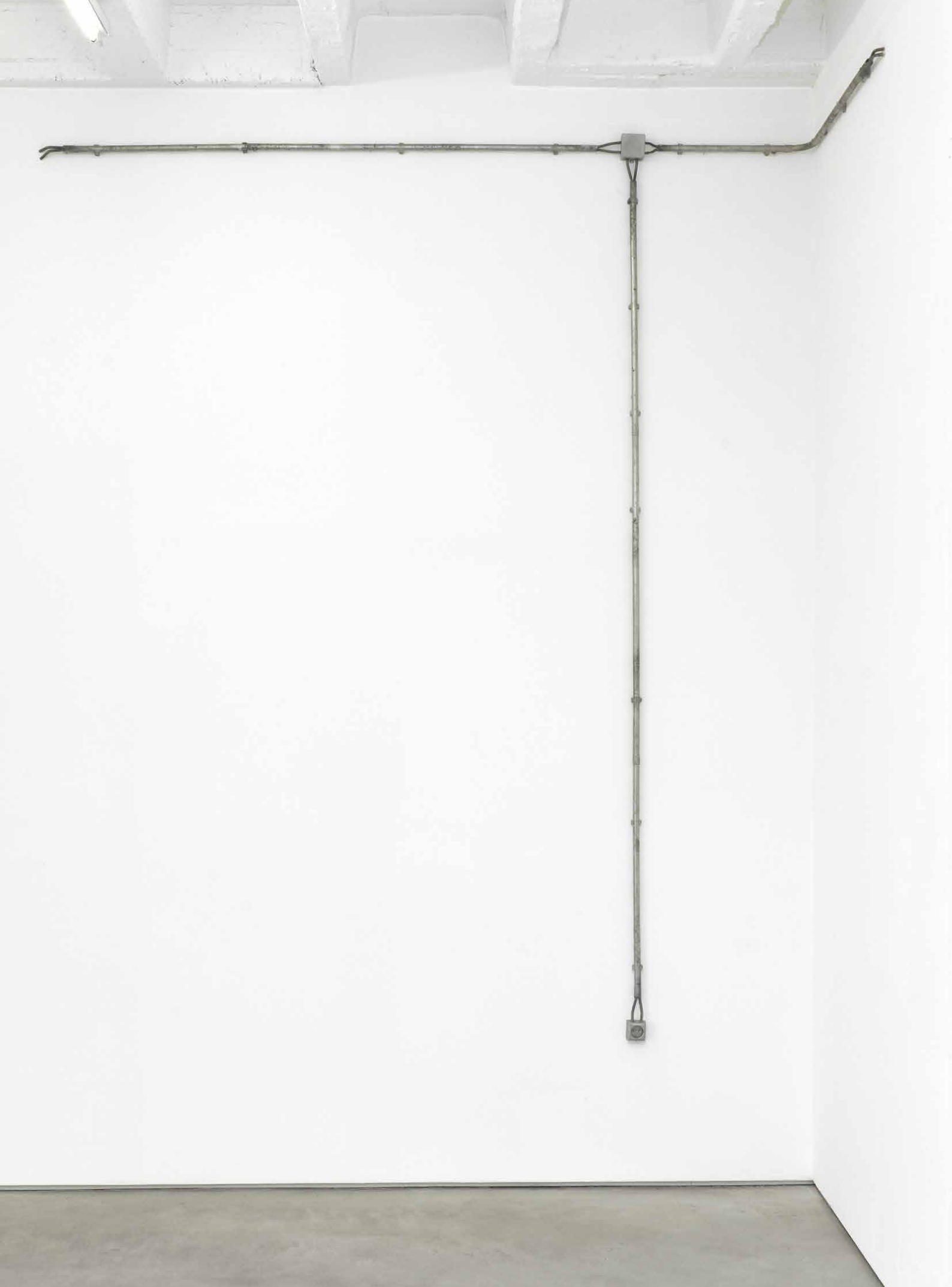
Leitung auf Putz / Conduit Surface Mounted, 2012 Aluminum
